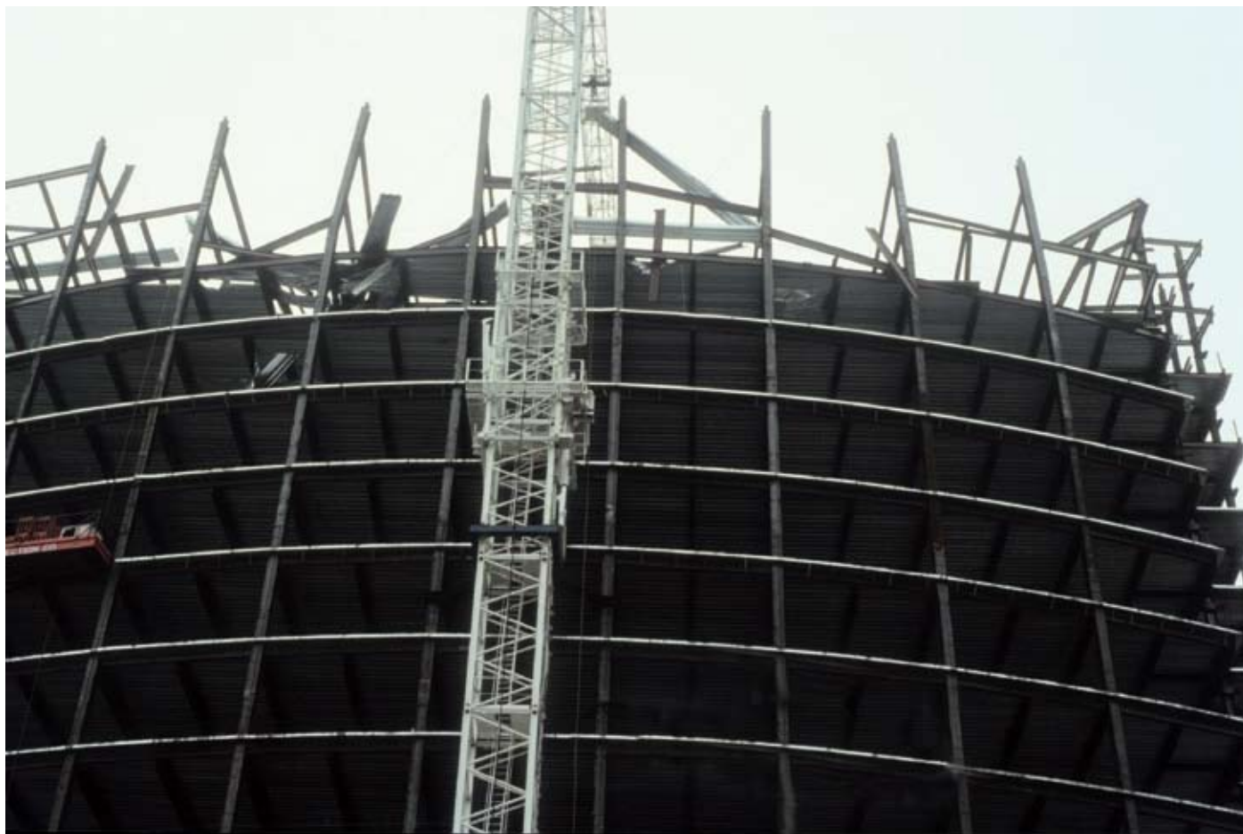
FIGURA 2. DAÑO EN UN EDIFICIO EN CONSTRUCCIÓN DURANTE EL TERREMOTO DE LOMA PRIETA, EEUU, 1989. VARIAS ELEMENTOS ESTRUCTURALES QUE SE ENCONTRABAN SIMPLEMENTE APOYADOS CAYERON DAÑANDO A LA ESTRUCTURA Y MAQUINARIA.
