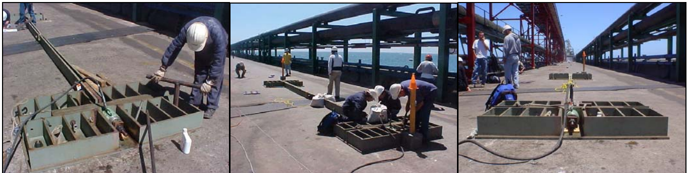
Figura 3. 2: Proceso de montaje del Sistema de tiro
