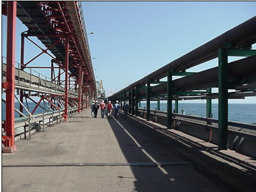
Figura 2. 2: Vista del Puente de Acceso
