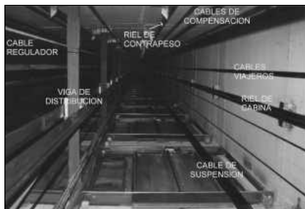
Fig.2.3: Ducto de circulación y componentes.
