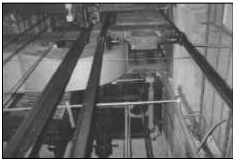
Fig.2.5: Deformación permanente del riel y descarrilamiento del contrapeso.
