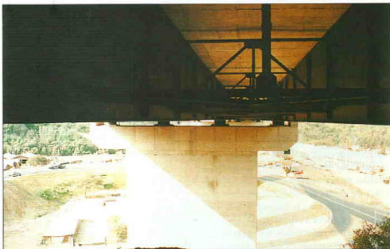
Detalle del puente Marga-Marga
